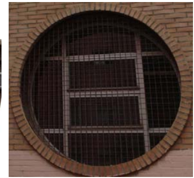
(c) Extracción de la ventana rectificada
